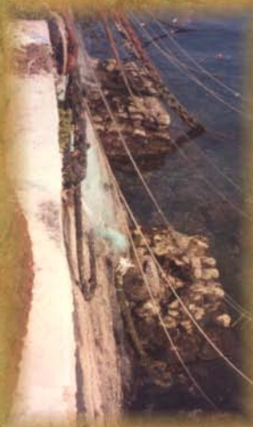
Detalle de los viejos cimientos del muelle castreño visibles en bajamar
